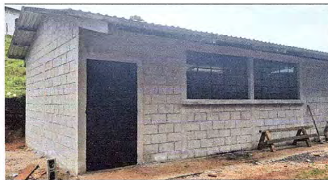
Foto 6: Imagen del aula No. 1 Puerta nueva instalada.
