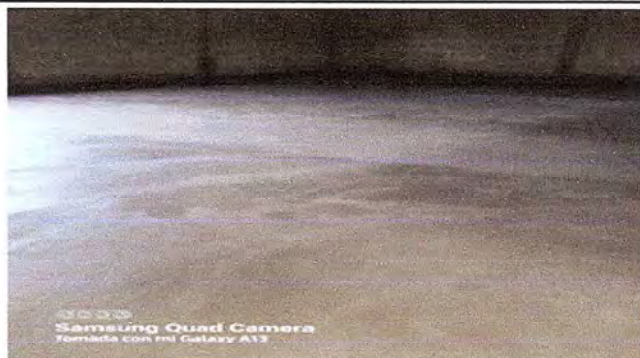
Foto 2: Imagen de aula No. 1 piso terminado.
