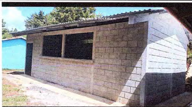
Foto 1: Imagen del aula No. 1 Habilitación de pared terminado.
