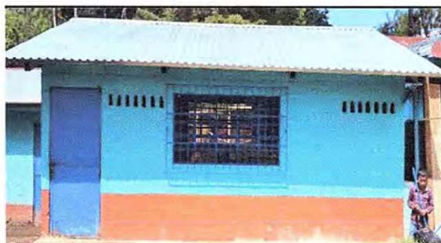
Foto 4: Aula 2 estructura de techo de metal e instalación de láminas.
