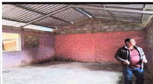
Foto 5: Vista del aula No. 2 sustitución de piso de concreto.
